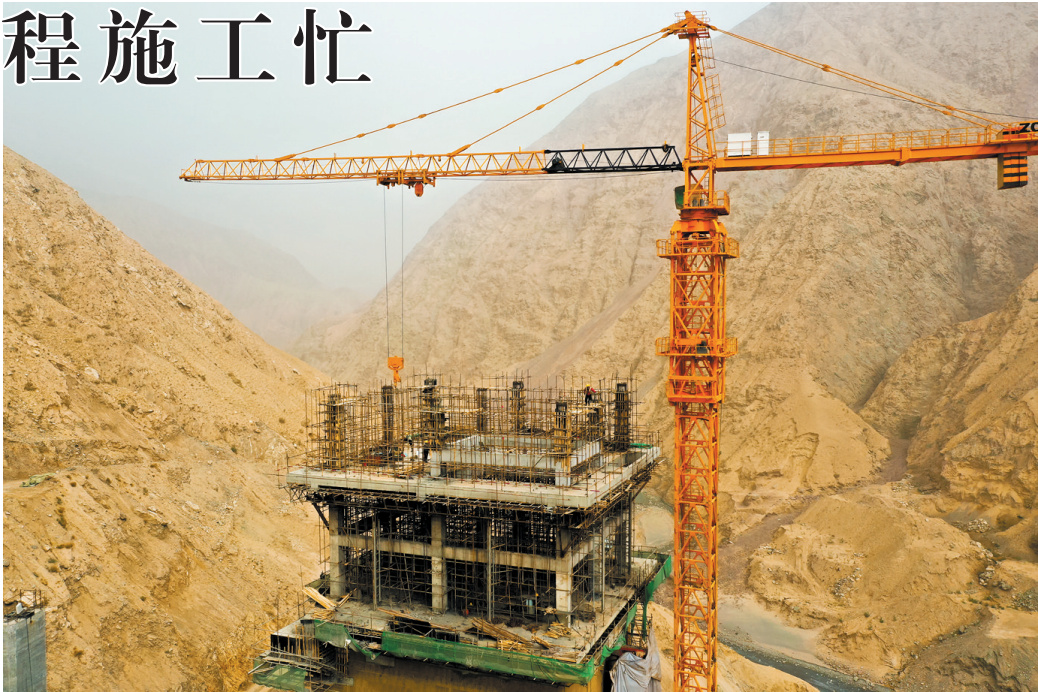
尼雅水利枢纽工程联合闸井管理房正在加紧施工。
