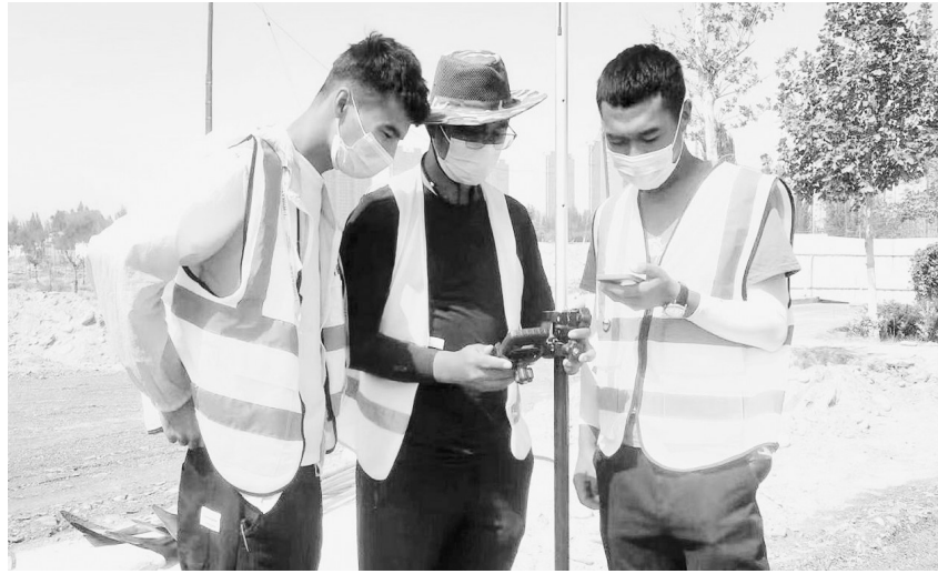
工作人员正在对施工路面进行测量。
