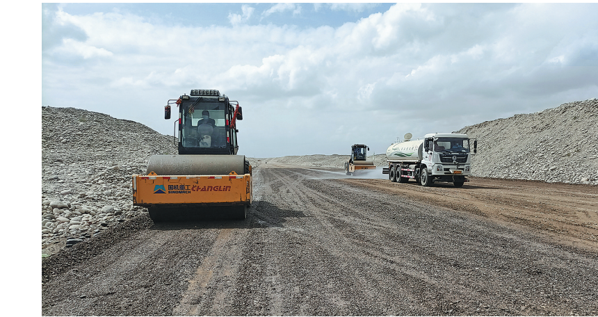
施工现场,压路机、洒水车加紧作业。 地区融媒记者 买合木提摄
