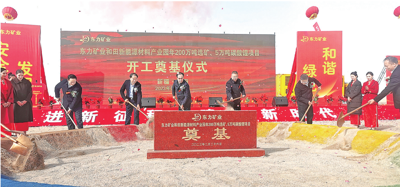
2月26日,东方矿业和田新能源材料产业园年200万吨选矿、5万吨碳酸锂项目开工奠基。
