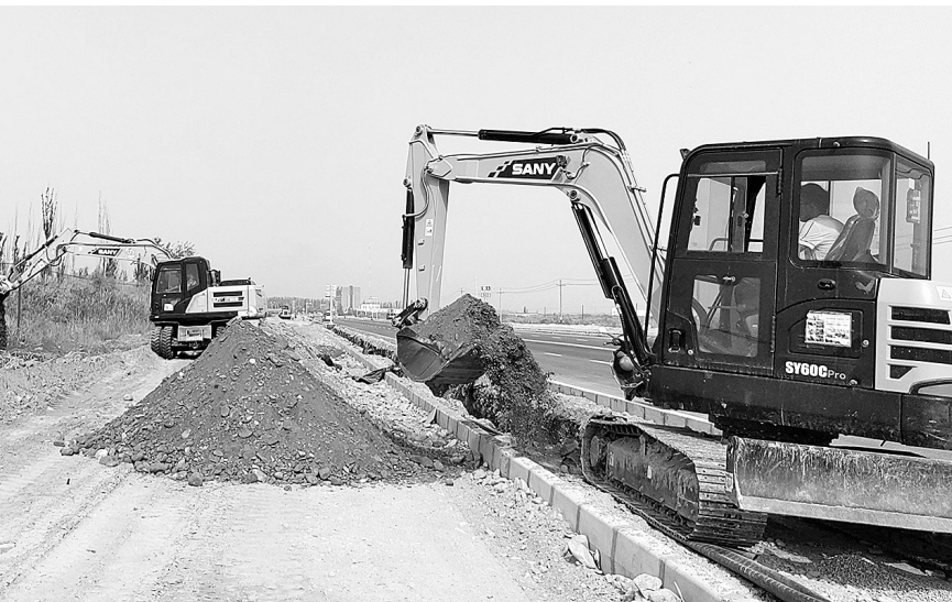
民丰县G315国道(尼雅乡—若克雅乡段)道路提升改造项目施工现场。地区融媒通讯员 古拉因木摄
