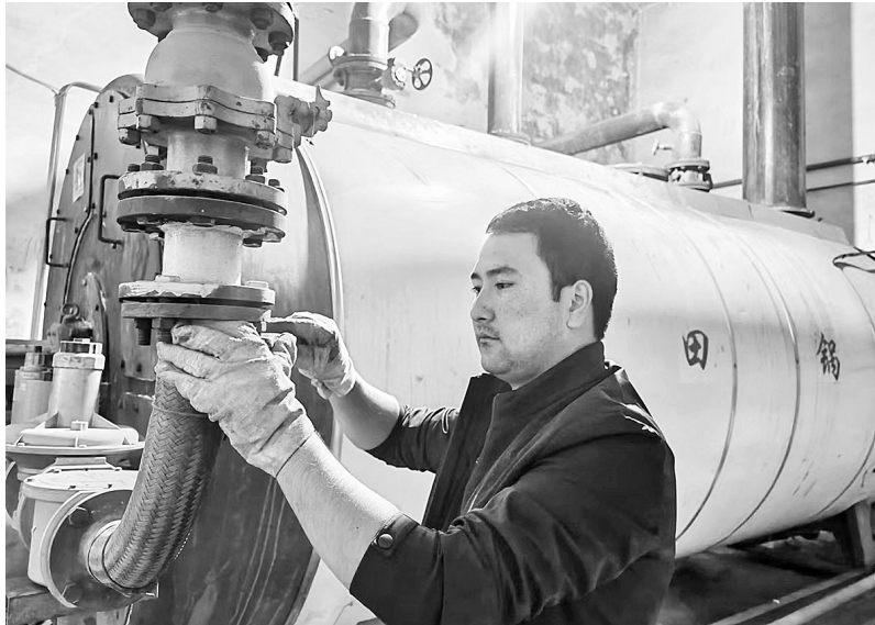
供暖企业工作人员对集中供暖小区锅炉及设备进行保养检修。地区融媒记者 古哈尔尼沙摄
