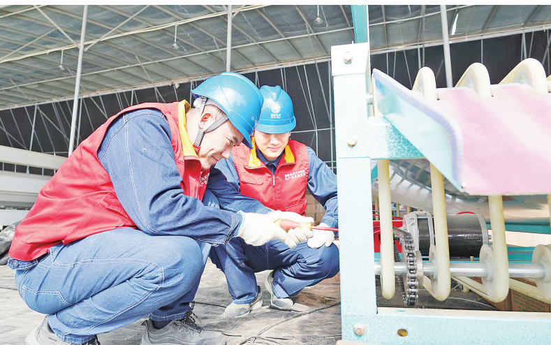
2月26日,国网策勒县供电公司服务队工作人员在排查大棚内用电安全隐患。
