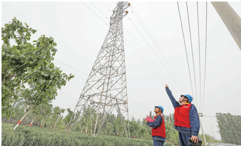
5月1日，国网和田供电公司输电运检中心员工庞笠和王天正在对110千伏玉白线1948线路进行巡视。地区融媒记者 许晓龙摄
