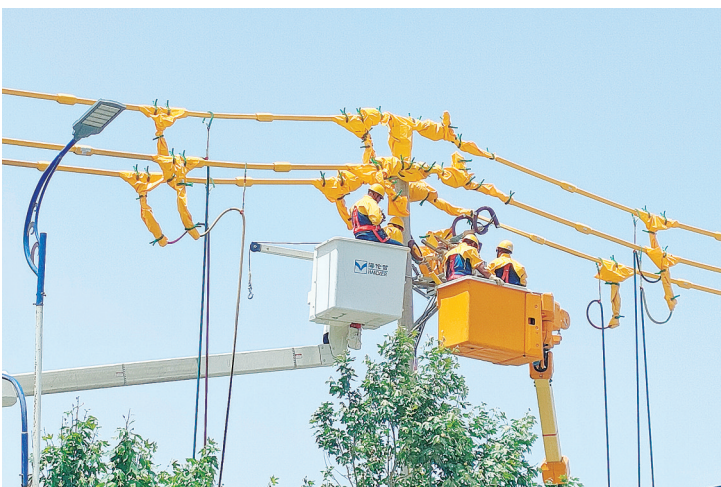
5月29日,国网和田供电公司施工人员首次采用配电网带电作业新技术作业。 地区融媒通讯员 魏广友摄
