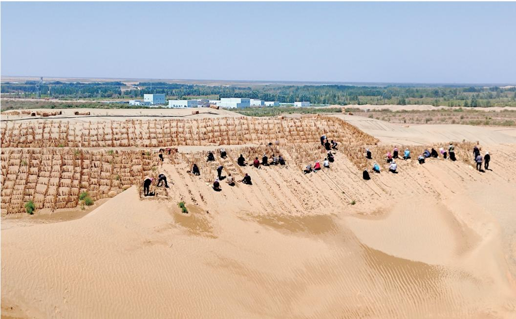
6月3日,在和田县东防沙治沙综合示范区“梯田式”治沙现场,治沙工人正在沙丘坡面上扎设草方格。
