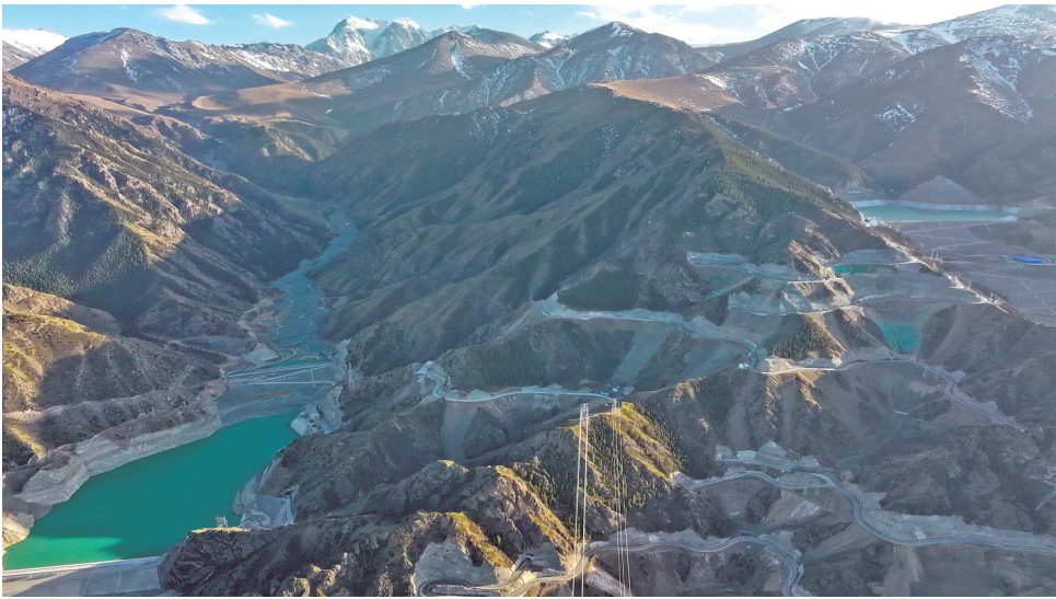
这是四月二十三日报拍摄的国网新源新疆阜康抽水蓄能电站上下水库(无人机照片)。
