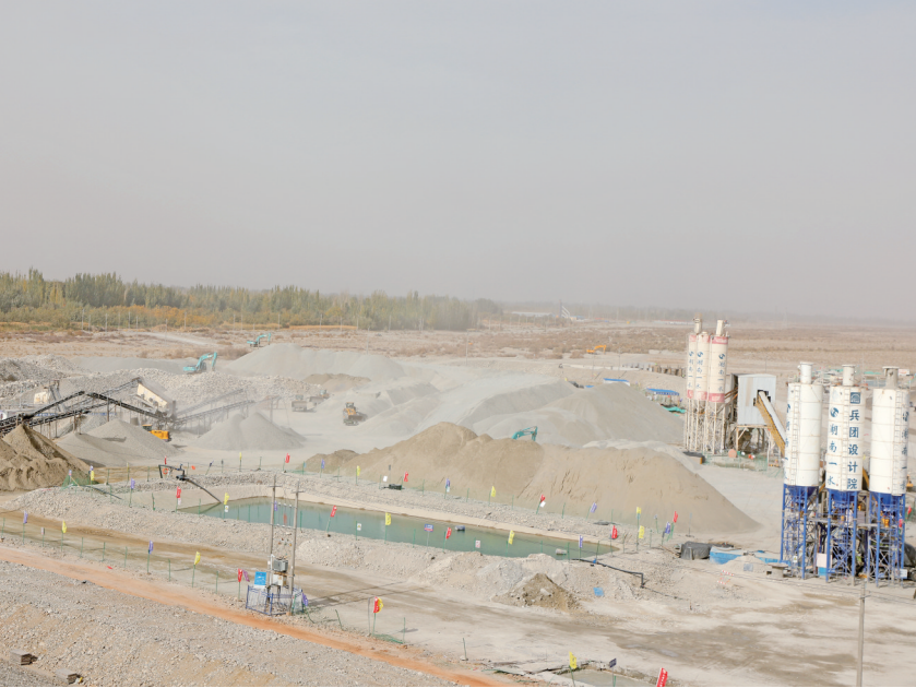
正在加紧修建中的桑株河恰斯干水库。
