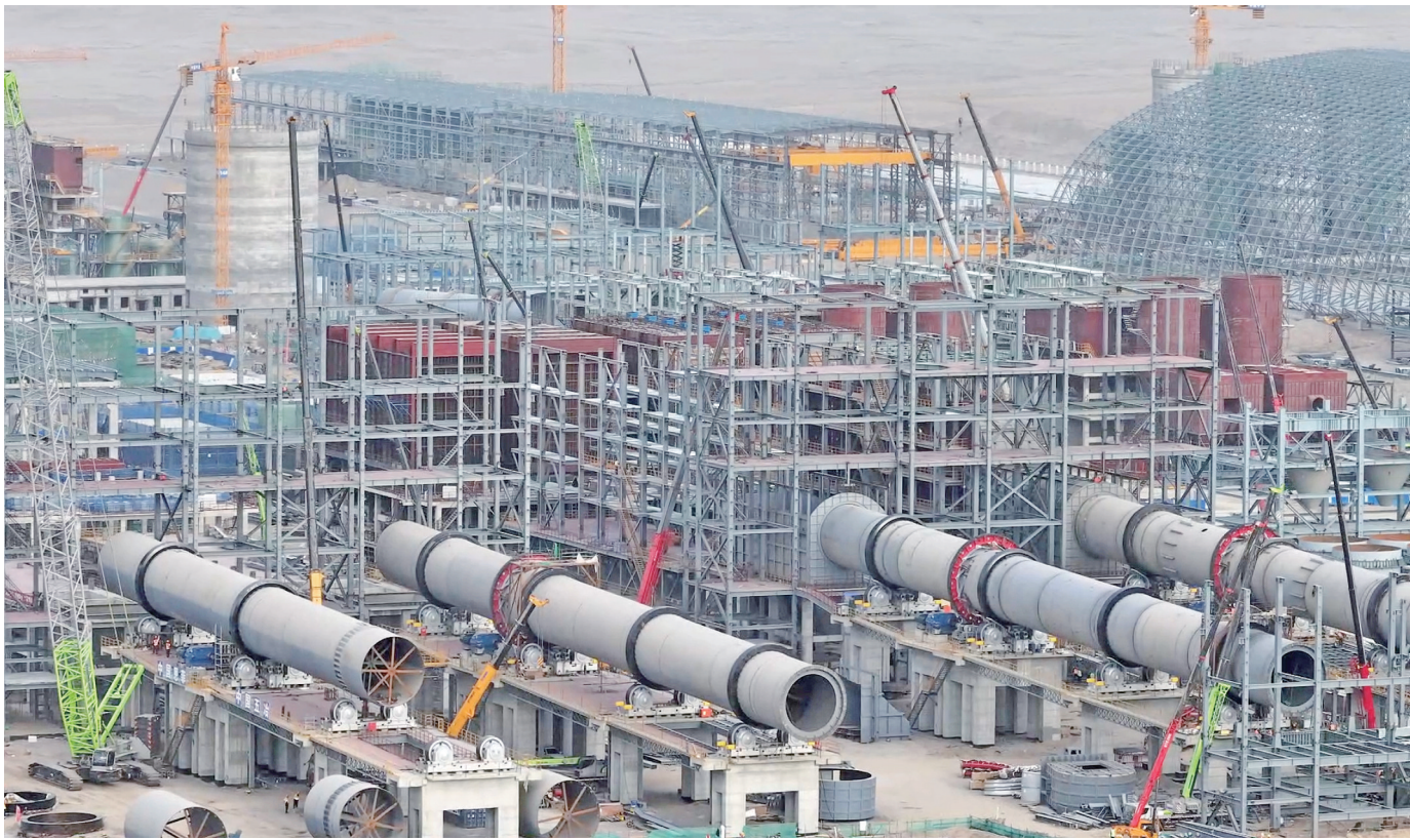
新疆昆仑铝业有限责任公司的60万吨铅锌冶炼项目施工现场,回转窑已经吊装完成。
