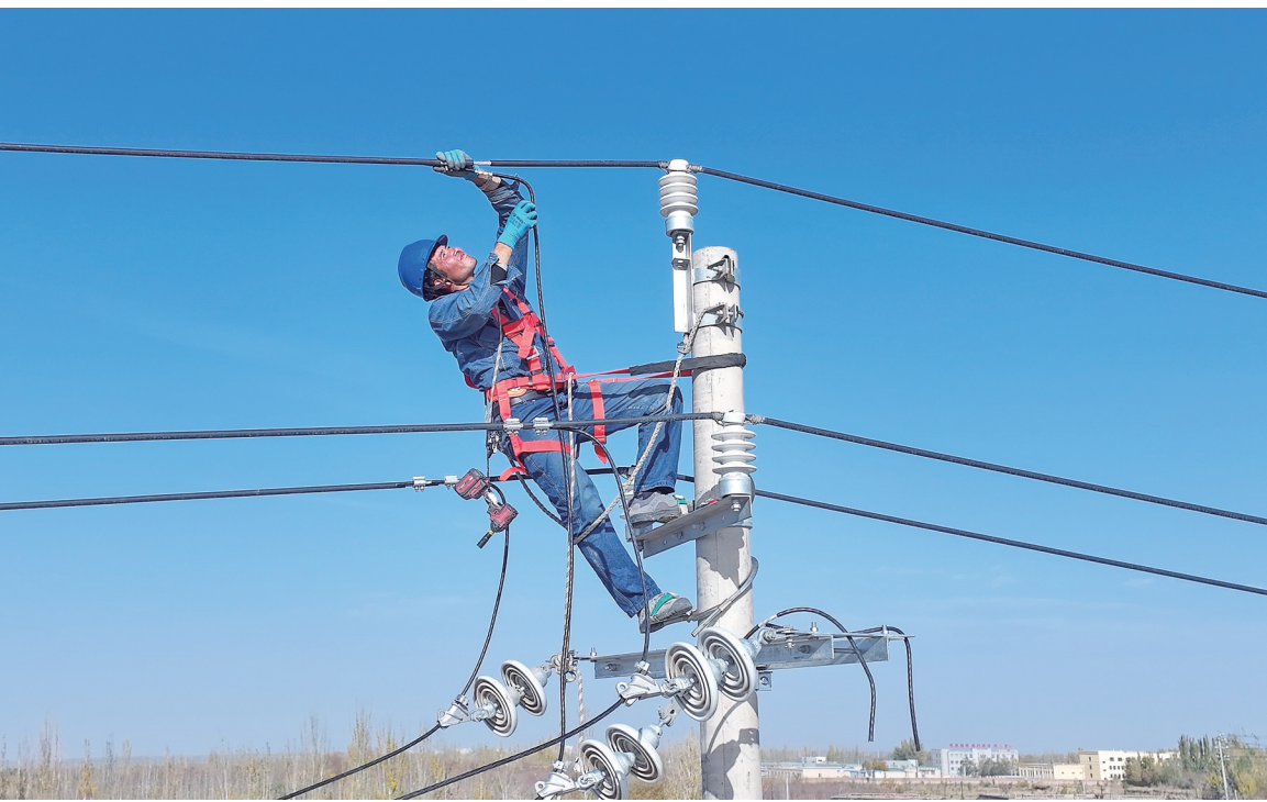
国网皮山县供电公司工作人员正在升级改造电网线路。地区融媒记者 阿卜来提摄
