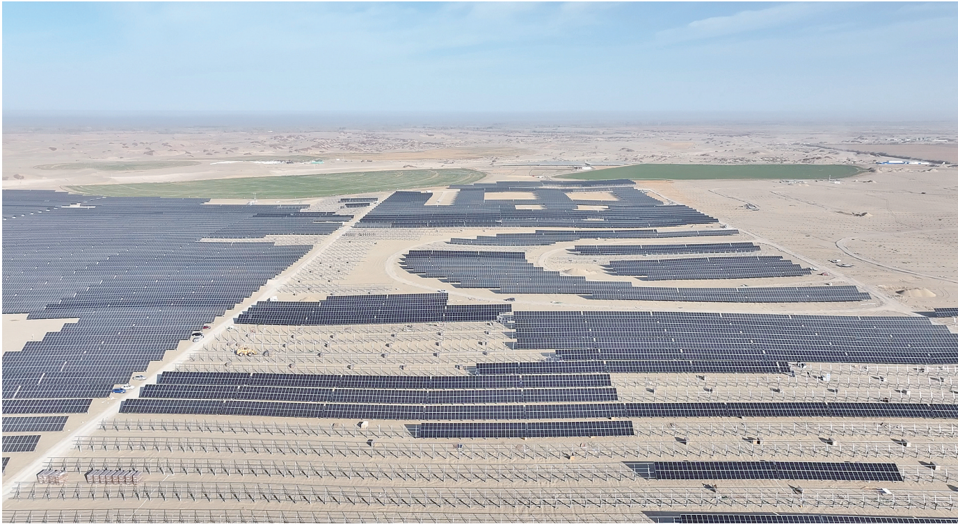
位于洛浦县拜什托格拉克乡的中广核新疆洛浦县50万千瓦光伏治沙示范项目施工现场(11月21日,航拍图)。
