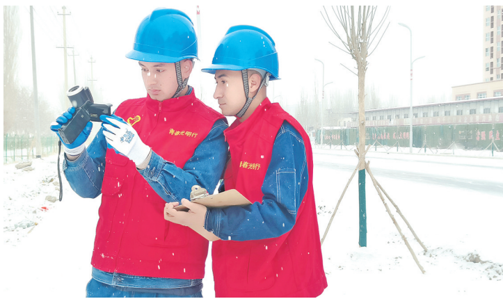
工作人员对辖区内配电线路进行特巡。
