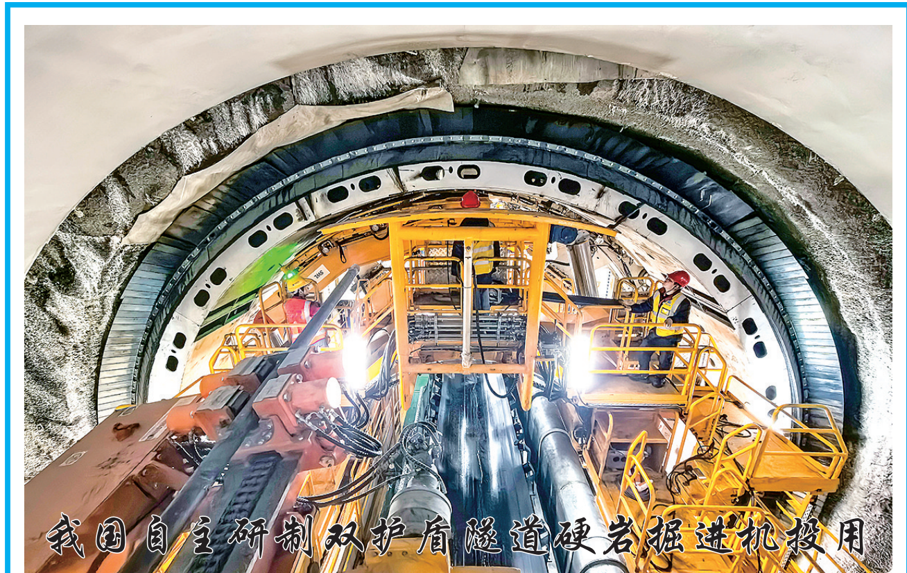
1月5日拍摄的引江补汉工程首台双护盾硬岩掘进机“江汉平安号”掘进施工现场。1月5日,由中国南水北调集团江汉水网建设开发有限公司联合中铁装备、中铁三局共同研制的引江补汉工程首台双护盾硬岩掘进机“江汉平安号”在湖北省宜昌市夷陵区顺利掘进始发。“江汉平安号”双护盾硬岩掘进机开挖直径11.93米,总长约180米,工作时可实现掘进作业和管片安装同步进行。
