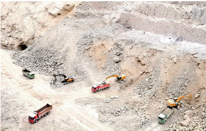
2月4日,在和田玉龙喀什水利枢纽工程施工现场,大型机械正在挖运土石方。地区融媒通讯员 韩丽摄
