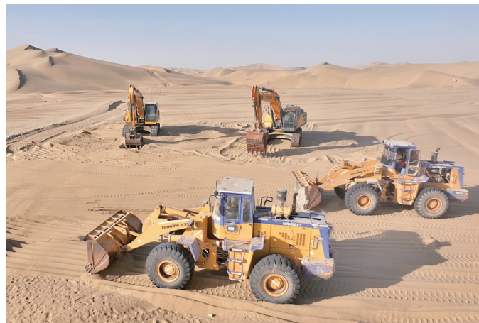
2月10日,策勒县沙海玉湖景区建设项目施工现场。
