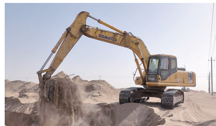
在后河坝防沙治沙阻击战区,挖掘机正在开挖地下管道。地区融媒通讯员 图拉罕摄
