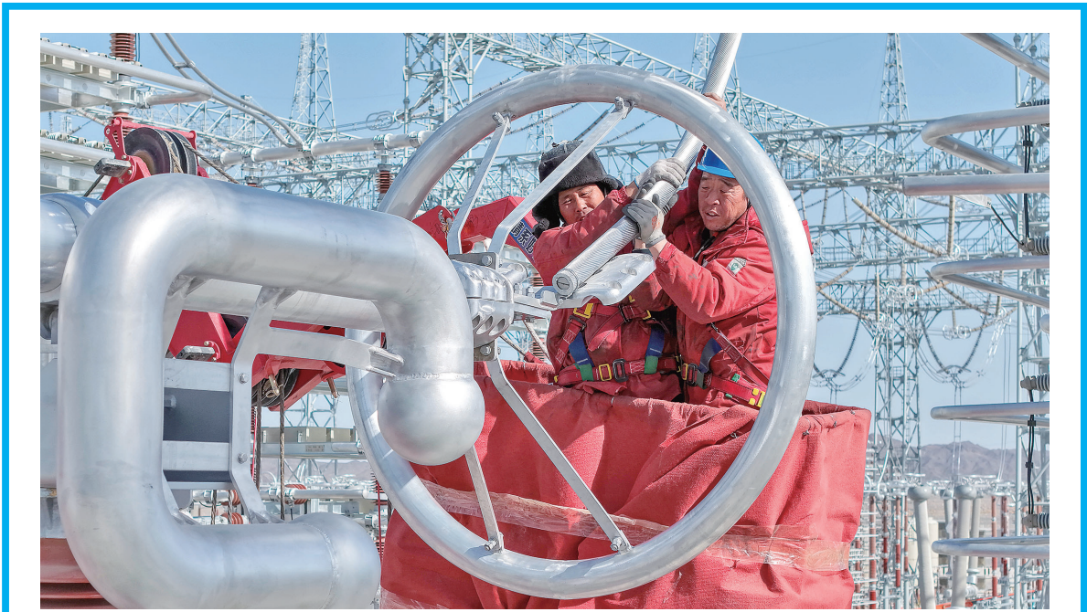
在哈密—重庆±800千伏特高压直流输电工程新疆送端站——巴里坤换流站，施工人员进行电容器组设备引线安装(3月21日摄，无人机照片)。 近日，国家“十四五”重大工程——哈密—重庆±800千伏特高压直流输电工程(简称“疆电入渝”工程)新疆送端站——巴里坤换流站顺利完成14台双极低端换流变压器的安装工作，标志着我国重要的“沙戈荒”新能源外送大通道建设取得关键进展。 新华社发 冯洋摄
