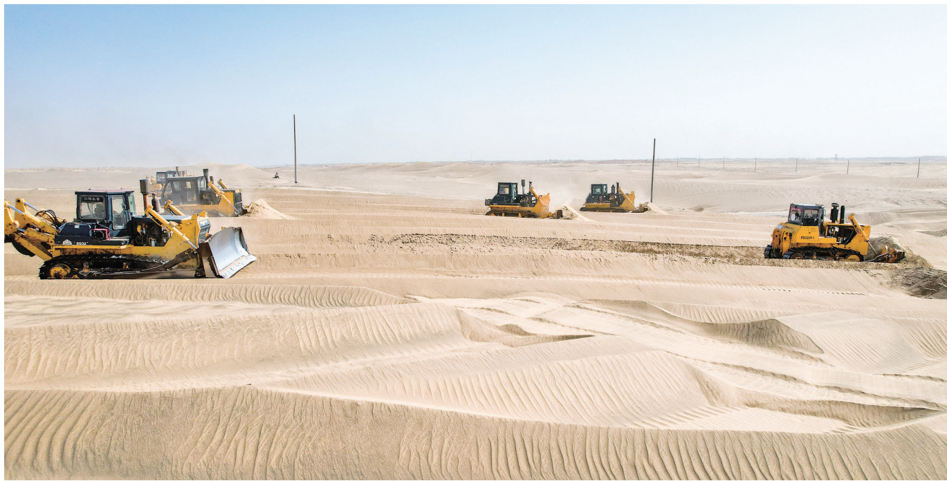
在民丰县后河坝防沙治沙区,推土机正在推平沙丘。
