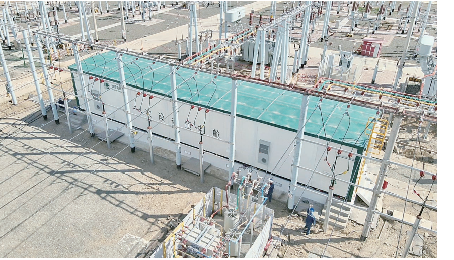
近日,国网塔城供电公司实施的110千伏恰夏变电站10千伏设备预制舱改造工程顺利投运。
