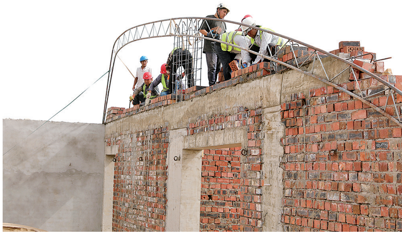
工人进行大棚建设。
