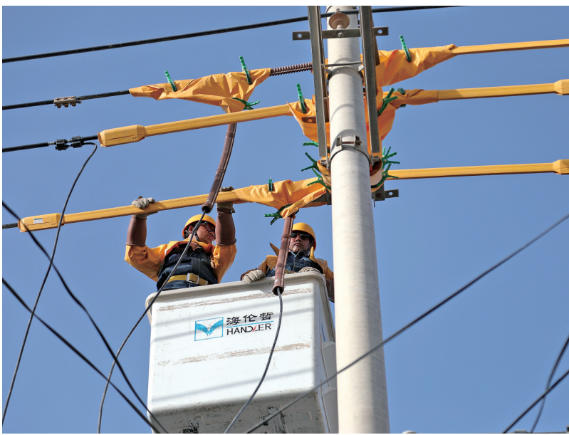
国网和田市供电公司工作人员检查线路供电情况。 供电公司供图
