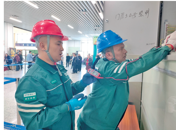
工作人员在和田昆明机场大厅测量配电箱电流和电压。(图片由国网和田市供电公司提供)
