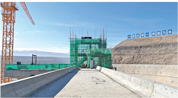
策勒河昆仑水利枢纽项目建设工程现场。
