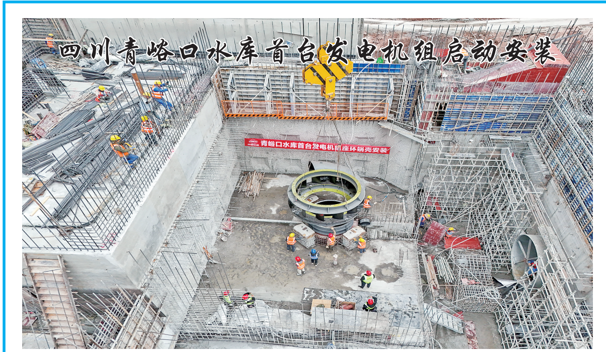
12月20日,由中铁十一局承建的四川青峪口水库项目3号机组座环、蜗壳顺利吊装,标志着该工程首台水轮发电机组进入核心部件安装阶段。该项目将安装3台容量为6.67兆瓦水轮发电机组,总装机容量20兆瓦,兼具防洪、供水和发电功能。青峪口水库位于四川省巴中市通江县,是国家150项重大水利工程、国家“十四五”规划102项重大工程之一。 新华社记者 王曦摄
