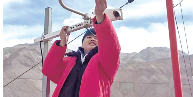
工作人员对县域区域自动气象观测站进行巡检维护。地区融媒通讯员 康维新摄
