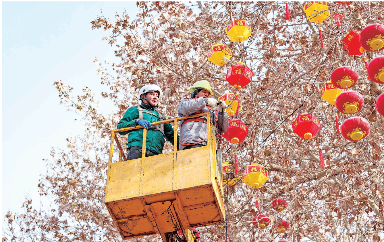
2月2日,工作人员安装彩灯。
