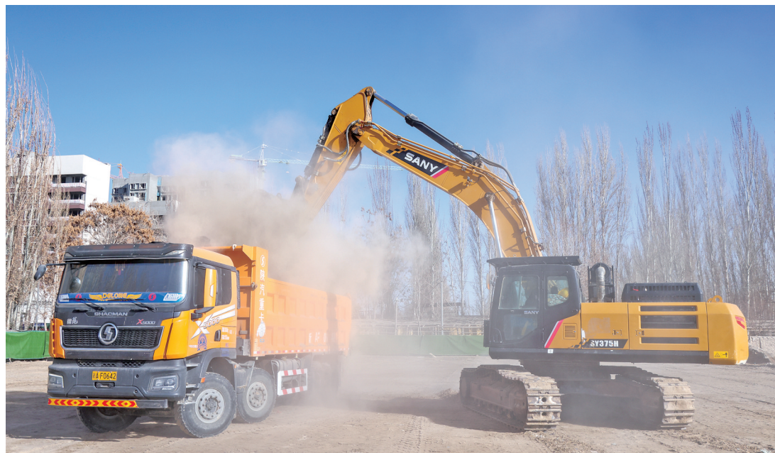
二月二十五日,和田市一季度项目开复工现场。地区融媒记者 张亚辉摄
