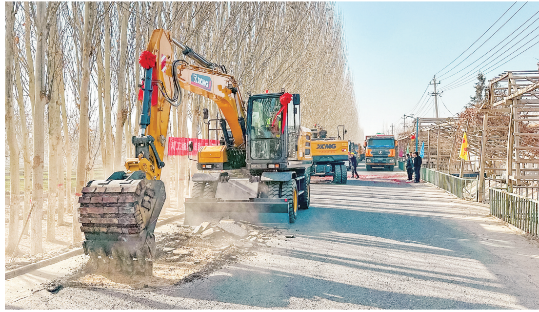
2月25日,地区2026年农村公路建设项目在和田县罕艾日克镇恰喀尔村正式开工复工。 地区融媒记者 伊尔番摄
