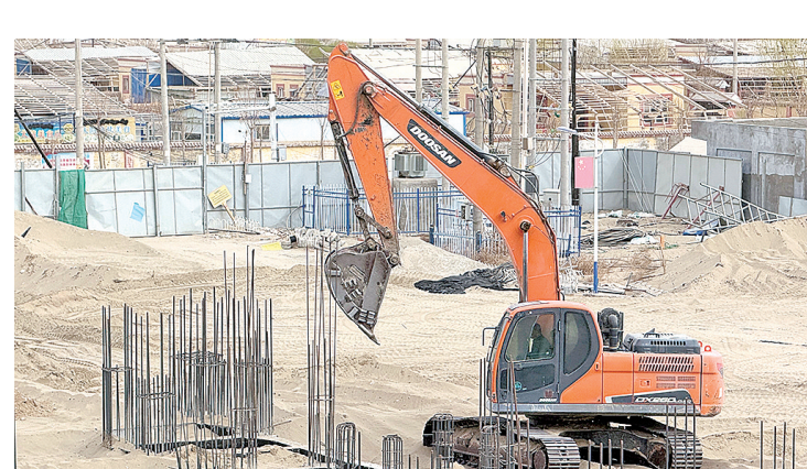
3月10日,施工机械开始作业。地区融媒记者 努尔古再丽摄
