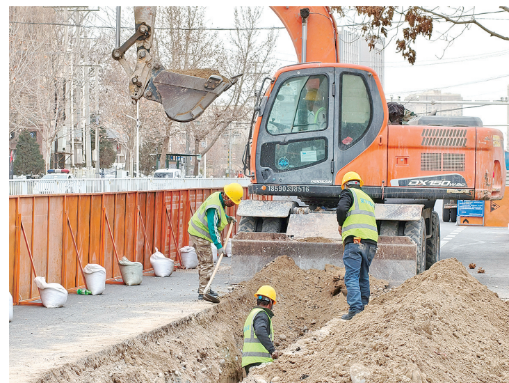
工作人员在和田市古江南路路段施工作业。地区融媒记者 巫依轩摄
