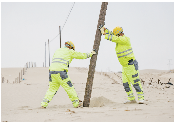
艾比布拉·图尔托合提与同事将倾斜的光缆杆扶正。
