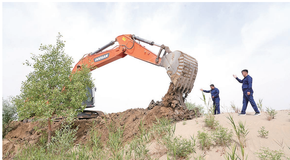
5月21日,在和田县色格孜库勒乡艾兰木布隆村二闸口,大型机械正在清理灌溉渠内淤积的泥沙。
