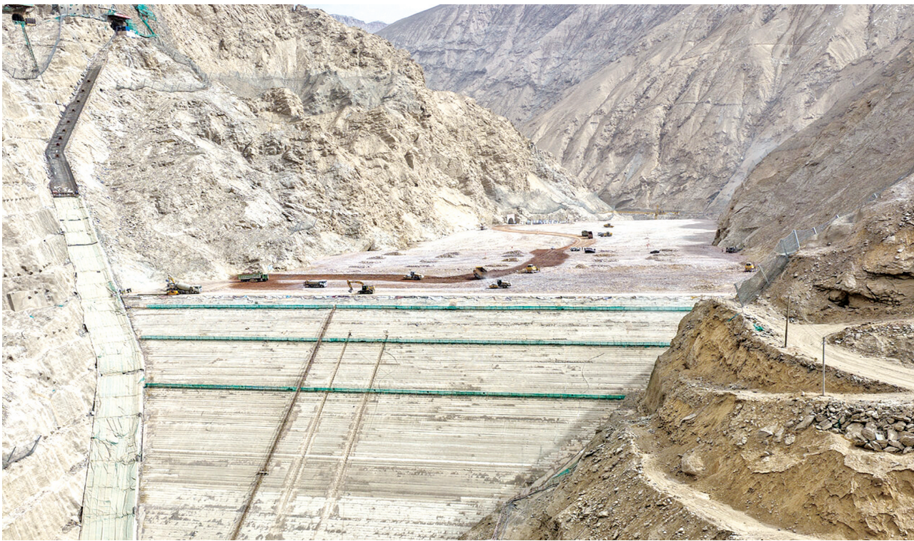
在玉龙喀什水利枢纽工程建设现场,施工人员进行大坝填筑与混凝土浇筑(2026年2月17日摄)。地区融媒体中心 许晓龙摄
