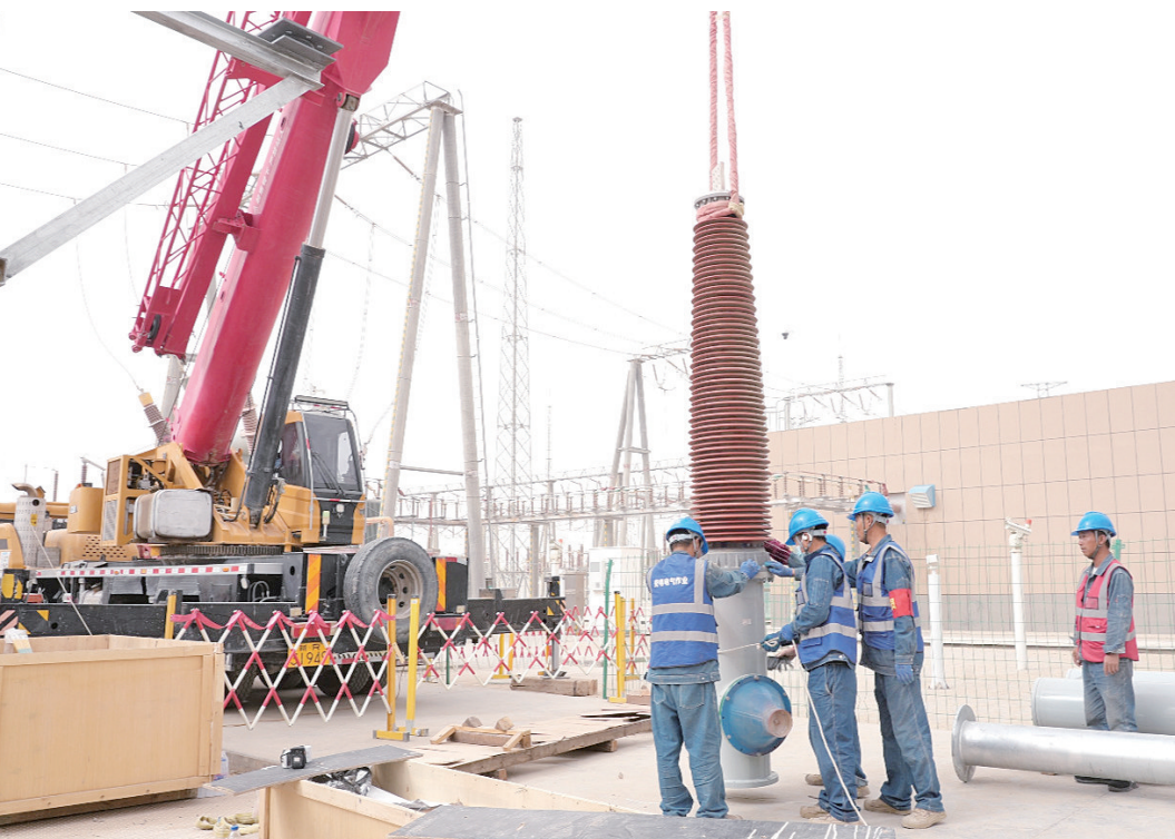
电网建设施工现场。
