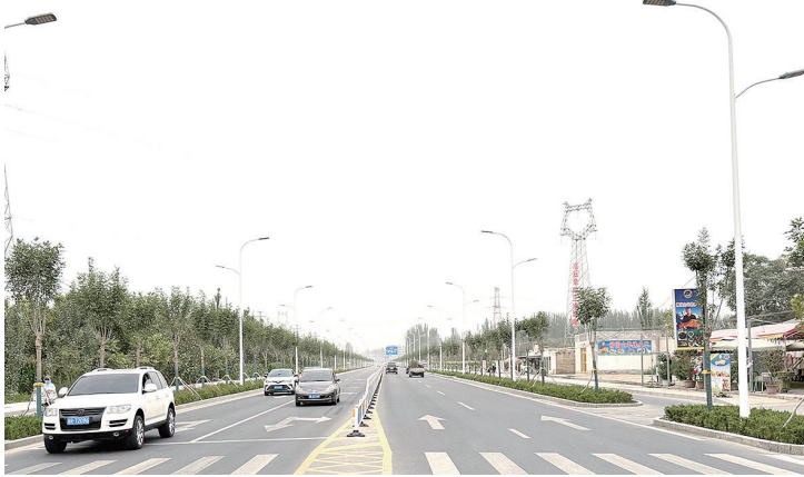
改扩建后的和田市北京西路。地区融媒记者 买合木提摄
